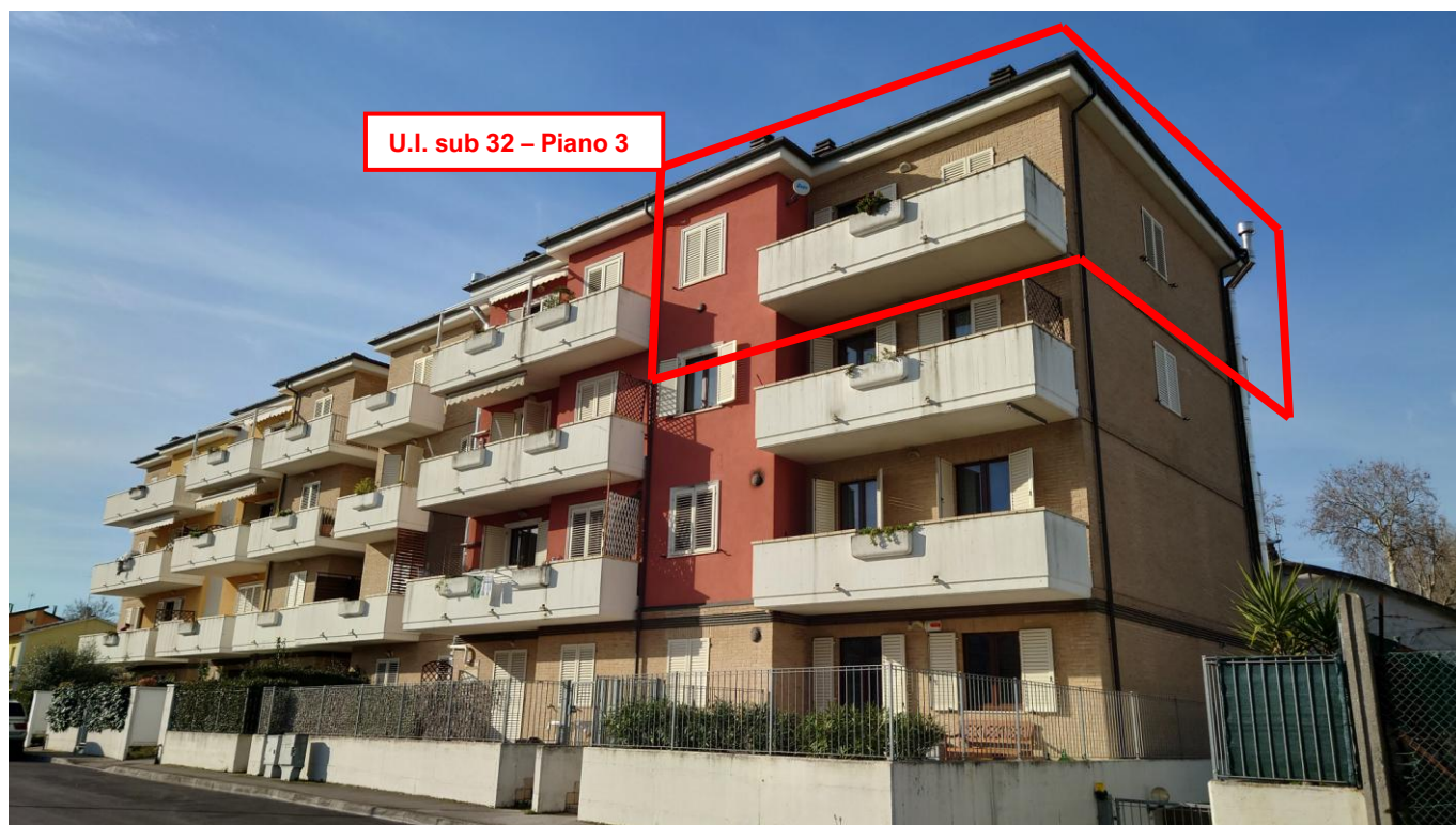
Vista esterna – fronte via Pacinotti (23/02/2026)
