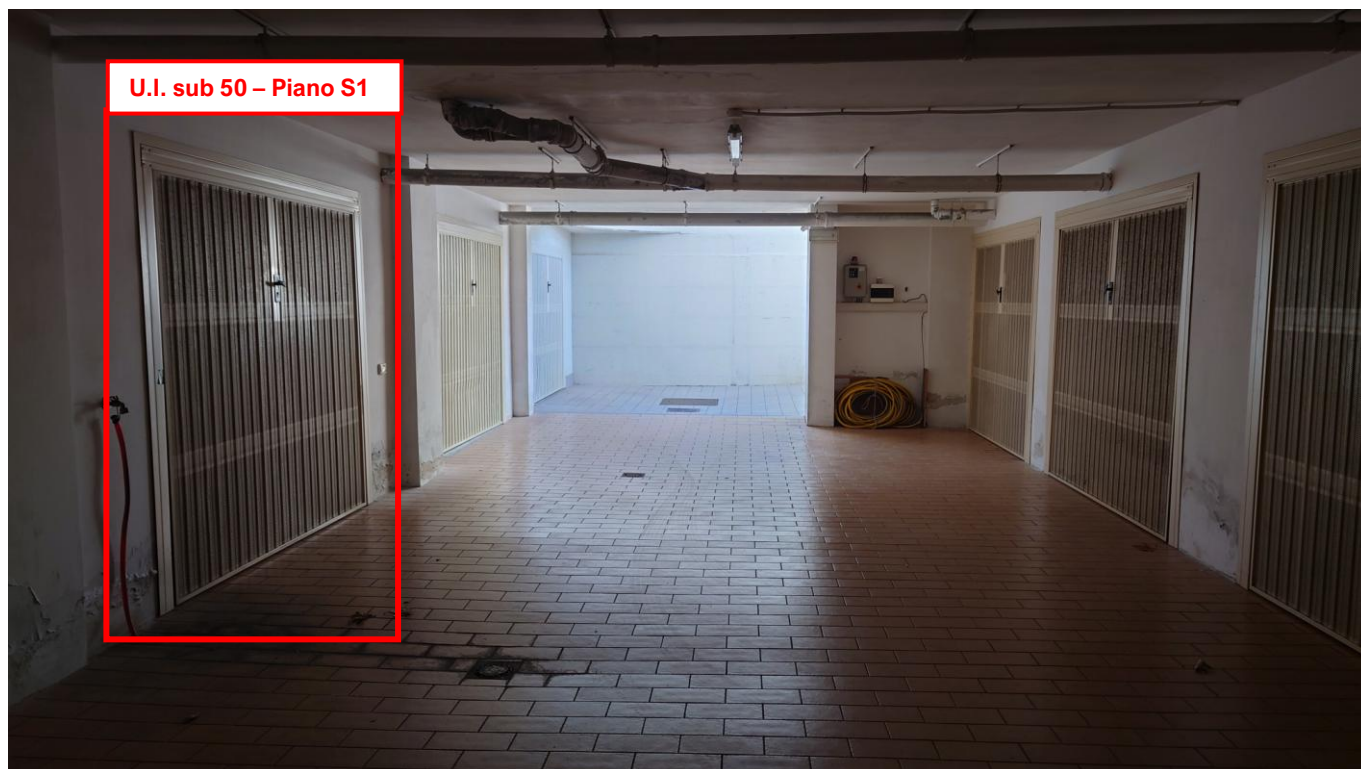
14 – Ingresso autorimessa condominiale
