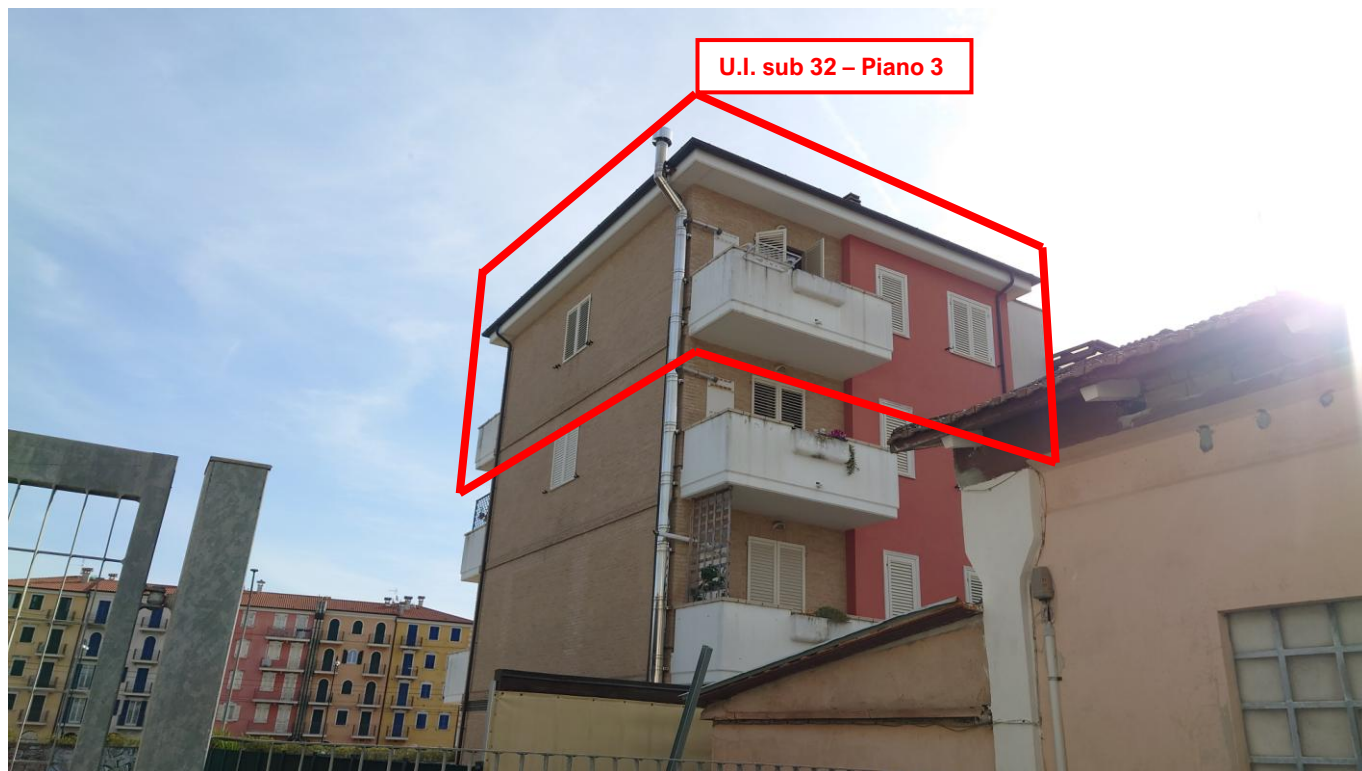
Vista esterna – lato posteriore (23/02/2026)
